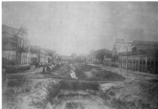
Figura 2: Drenagem da Bacia do Reduto
